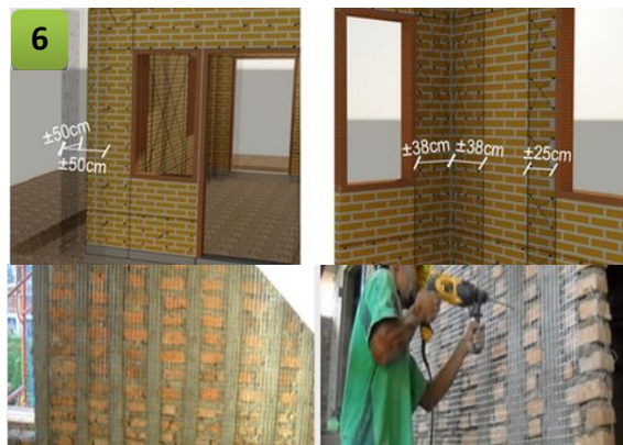
Rumah Aman Gempa dengan Perkuatan Dinding
